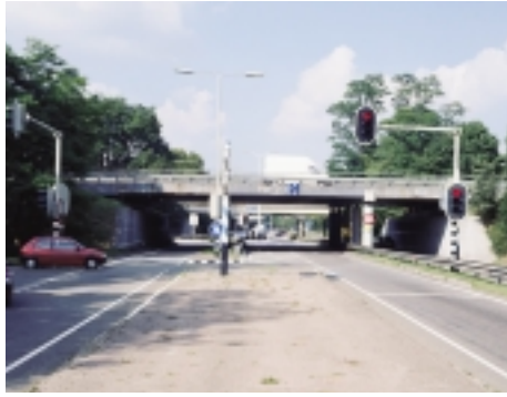
fig.3.2 De Amersfoortse weg met het viaduct bij de A12
